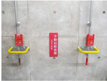
手動起動装置に保護ガードを設置
