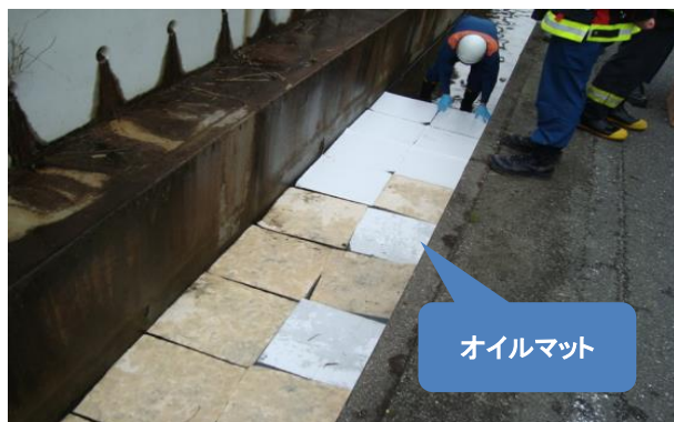
(写真2) オイルマットで油を回収する様子
