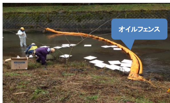
(写真3) オイルフェンスを設置する様子
