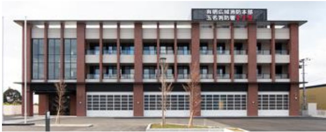
シャッター閉鎖時
